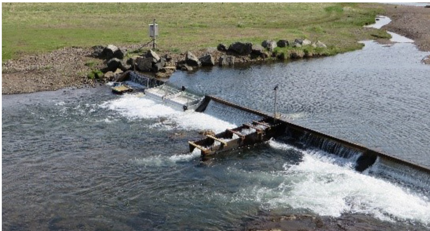
Mynd 35. Fyrirstaða í Vesturdalsá í Vopnafirði með búnaði til að veiða gönguseiði á leið til sjávar til talningar og merkinga auk búnaðar fyrir teljara til að telja fjölda laxa og bleikja sem ganga í ána. Mynd: Hlynur Bárðarson
