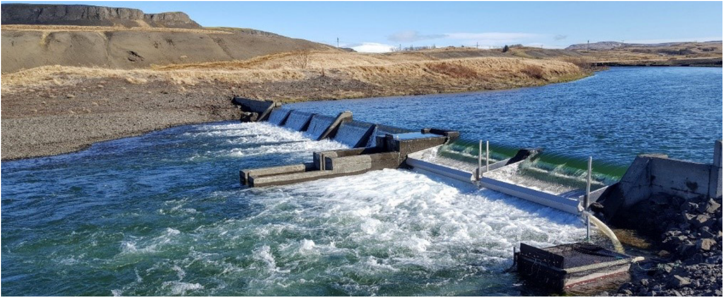
Mynd 30. Búnaður í Kálfá til veiða á laxaseiðum á leið til sjávar en þar er einnig búnaður til að telja og greina fullorðna fiska á göngu upp í ána. Mynd: Magnús Jóhannsson
